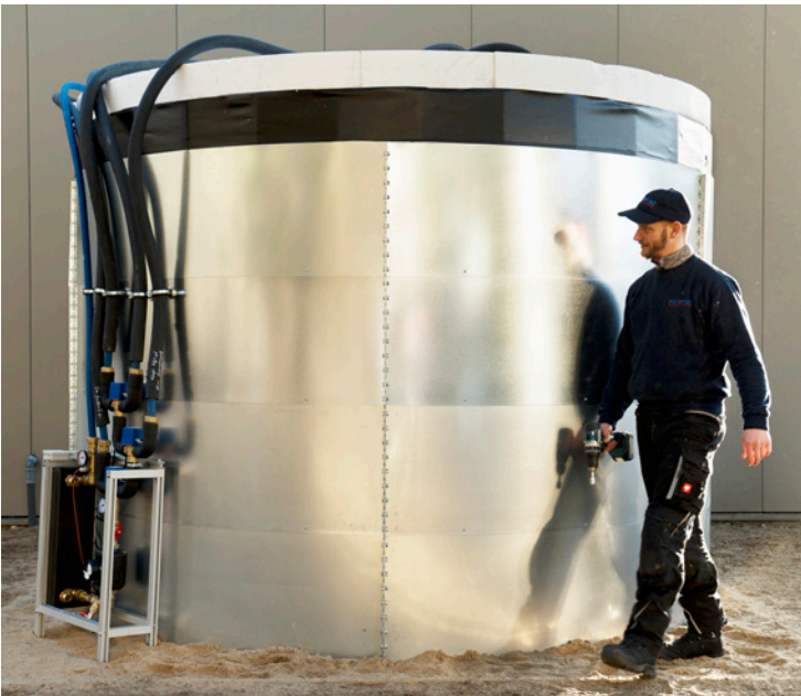
Leichter Aufbau des "VARIO": Das benötigte Werkzeug besteht nur aus Maulschlüssel und Akkuschauber!
