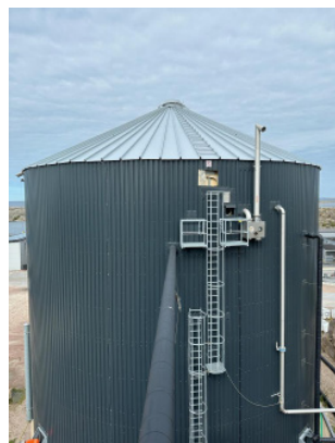
Coperchio per biogas Fenotec in uso nel serbatoio di stoccaggio del biogas
