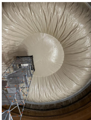
Coperchio per biogas Fenotec in uso nel serbatoio di stoccaggio del biogas
