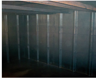
2. Gereinigter Tank von innen
