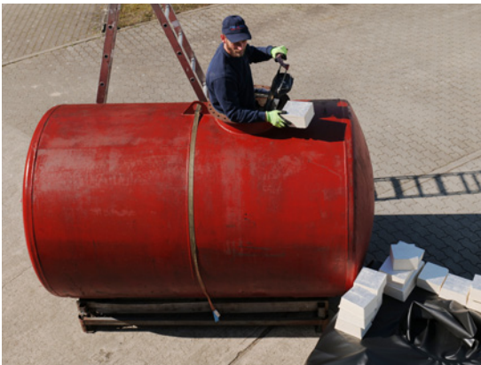
Der Einbau erfolgt mit Dämmelementen und einer hochwertigen Kunststoffinnenhülle.
