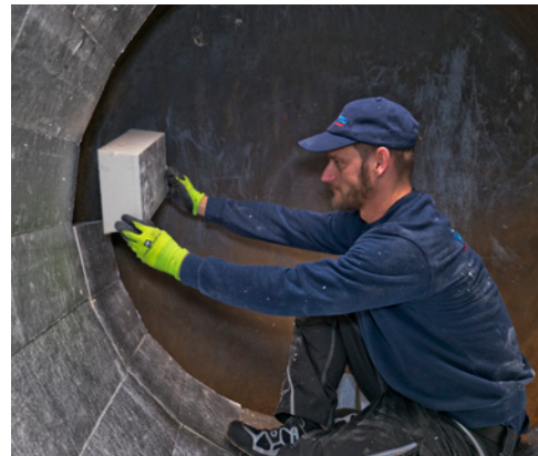
Die Dämmelemente werden schnell und passgenau eingebaut.
