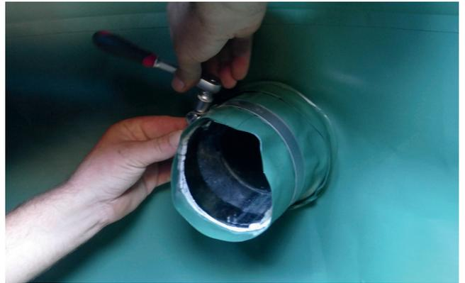
Die Zuläufe werden fixiert, abgedichtet und die Edelstahlschelle verschraubt.
