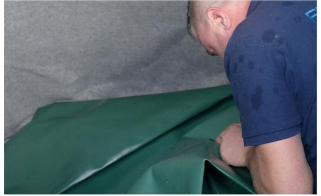
Die Auskleidung wird in den undichten Behälter eingebracht.
