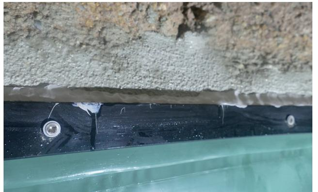
Nach der Fixierung am Zulauf wird die Auskleidung mit einer HD-PE-Schiene und Edelstahl-Schlagschrauben an der Wand befestigt, überstehende Folie wird abgeschnitten und der Rand versiegelt. Im letzten Arbeitsschritt wird, falls erforderlich, die Trennwand eingehängt und gespannt.
