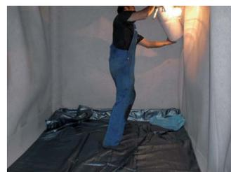
4. Nachdem die Hülle ausgerollt ist, wird das Deckenvlies auf der Hülle ausgerollt. Die Fixierung des Deckenvlieses wird mit dem Domhals und einem Klettbandstreifen auf der Hülle erreicht. Eine Teilung der Wandbahn ab einer Länge von ca. 11 Metern garantiert eine einfache Montage auch bei geringen Deckenhöhen und kleinen Dombdurchmessern.
