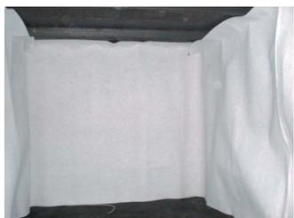
2. Eine Teilung der Wandbahn ab einer Länge von ca. 11 Metern garantiert eine einfache Montage auch bei geringen Deckenhöhen und kleinen Dombdurchmessern.
