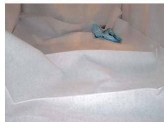
5. Mit dem Aufblasen der Hülle wird das Deckenvlies gegen die Tankdecke gedrückt. Vorhandenen Profile werden ähnlich einer Gewölbedeckeumschlössen wodurch eine übermäßige Foliendehnung in Eckenbereichen zusätzlich reduziert wird.
