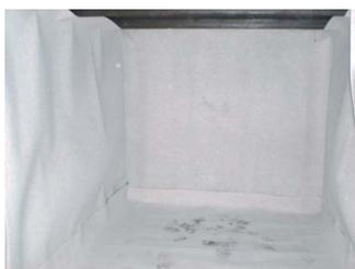
3. Die Bodenlage wird wie ein Teppich ausgerollt. Durch die umlaufende Überlappung zur Wandbahn ist eine vollflächige Auskleidung auch in den Übergängen zu Profilstreben gewährleistet.
