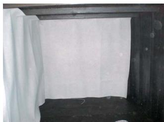
1. Die vorkonfektionierte Wandbahn wird zwischen die Wand und den Boden geklemmt.
