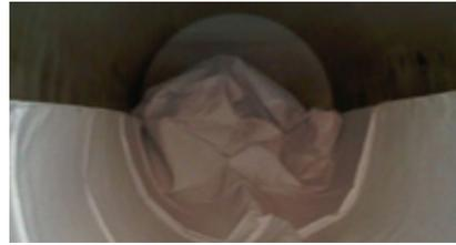
4. Das Vlies wird der Länge nach ausgerollt. Da die Länge des Vlies-sacks der Gesamtlänge des Tanks entspricht, ist dieser auf beiden Seiten in den Klöpperboden zu ziehen.
