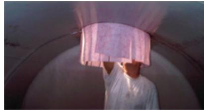
6. Der Dom wird für das Aufblasen der Innenhülle vorbereitet. Damit die Hülle am Dom nicht beschädigt werden kann, wird dieser möglichst ausgepolstert, beispielsweise mit einem Domhalspolster (separat zu bestellen).
