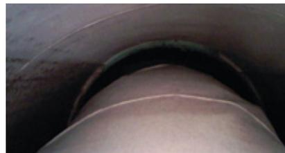
8. Innenhülle und Vlies werden in einem Stück aufgeblasen. Da das vernähte Vlies immer zu 100% den Tank bedeckt, kann es nicht verrutschen. Dadurch kann die Innenhülle auch bei einem eventuellen Abfall des Vakuums immer wieder aufgeblasen werden.
