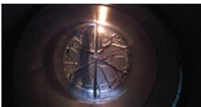
9. Die Innenhülle ist vollständig aufgeblasen. Sie liegt faltenfrei an, wobei im Bodenbereich der Schlauch verläuft, der schon vorab im Tank verlegt worden ist.
