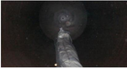
3. Das Vlies wird der Länge nach in den Tank eingezogen. Dabei darf die Verpackungsfolie erst im Tank gelöst werden, damit Fremdkörper wie z. B. Späne nicht mit in den Tank eingezogen werden.
