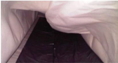
5. Die Innenhülle wird im Vlies-sack ausgerollt. Das Vlies kann gegebenenfalls mit Magnetknöpfen an der Tankdecke befestigt werden (separat zu bestellen). Die Innenhülle muss genau wie beim normalen Einbau richtig längs und quer verlegt werden.
