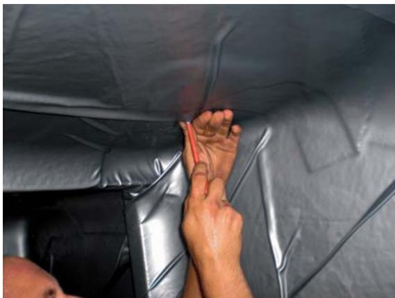
Nachdem die Innenhülle in gewohnter Weise montiert worden ist, wird die Folie unterhalb der Bohrlöcher durchstoßen.
