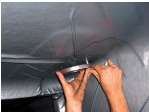
Der Flansch wird mit Sechskantschrauben positioniert.
