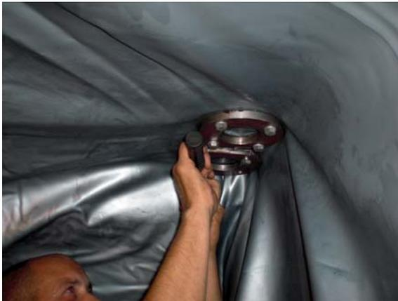
Die Hülle wird im Bereich der Rohre ausgeschnitten.
