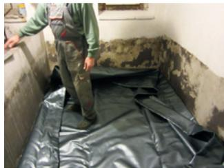
Der Boden wird mit Vlies ausgelegt und die passgenaue Tankraumauskleidung ausgebreitet.
