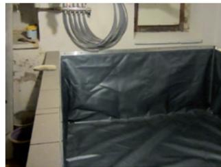
Der Boden wird glattgezogen und die Tankraumauskleidung mit einer Aluminiumschiene an der Wand montiert.
