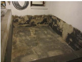
Der Tank wird entfernt oder mit einer Hebevorrichtung angehoben. Der Tankraum wird gesäubert.
